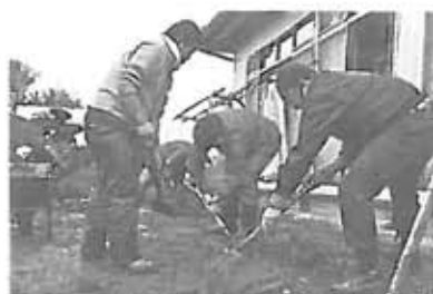
がれき撤去作業も(ロシナンテス 撮影)
